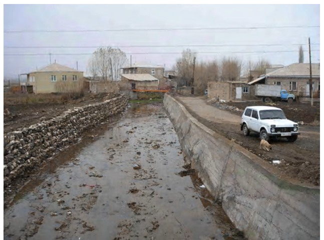
写真6 見返り資金により河川岸の護岸および橋梁工事が行われた。(ゲガルクニック州カルマール村)
