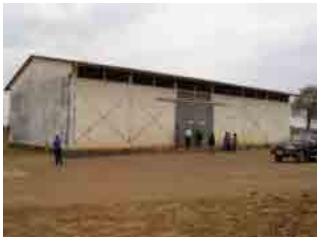
写真-7 <中央倉庫 (Chibombo地区)> 各地区 (District)のFSPの肥料を保管するため、食糧備蓄公社 (FRA)や種子会社の倉庫を借り上げている場合が多い。
