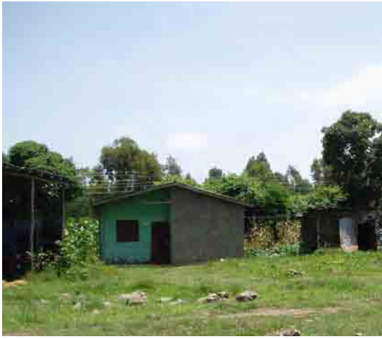
写真1 農業農村開発省から派遣されている、農業改良普及員の宿泊施設(ルメ アダマ農業協同組合連合内)
