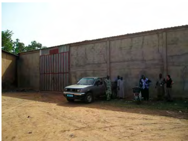
写真7 農業省が借りているマリ農作物公社（OPAM）の肥料倉庫（セゲー地方）
