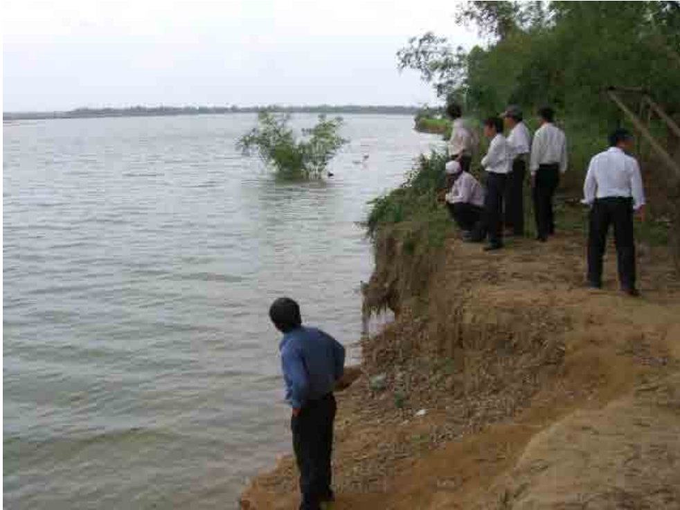
河岸浸食箇所(Thu Bon 川 Quang Nam 省)。写真奥の河川内にある竹は、以前陸であった場所を示している。
