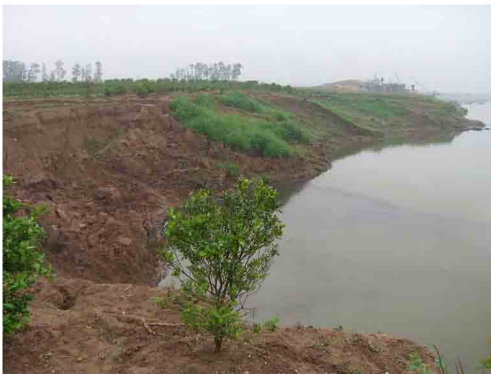
河岸浸食箇所 (Red River 川 Hung Yen 省)。河川の直ぐ横に農地が毎年激しく浸食されている。
