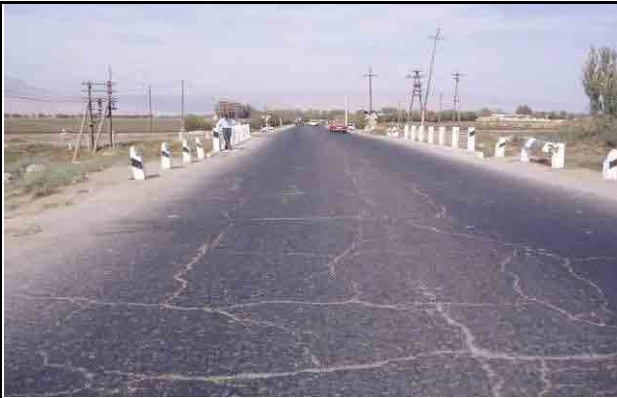
コルホゾバッドからクルガンチュベに向かう距離標 30+000 の鉄道との平面交差付近、網状クラックが路面を覆う
