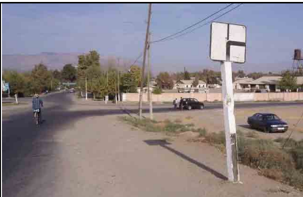
コルコソバッド市内へ入る手前の右折箇所縦断勾配が急、かつ平面曲線半径が小さい
