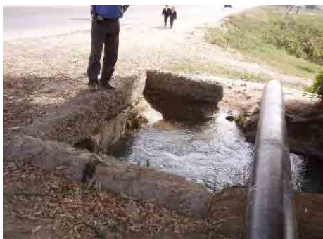
距離標 31+000 付近の横断管渠の灌漑排水で満流になっている呑口
