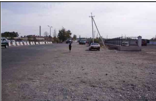
調査起点からコルホゾバッド方向を望む、路面の一部は未舗装となっている。
