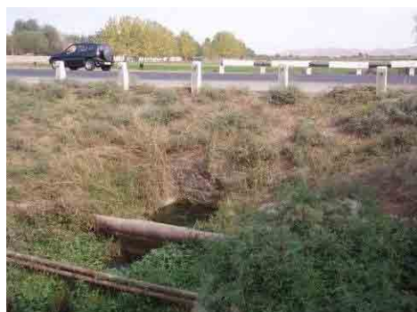
道路沿いに水道管（使用されていないものもある）と電話ケーブル管が敷設されている。
