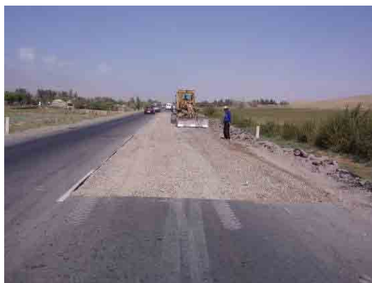
国道384号線ドシャンベ〜クルガンチュベ間のADBの有償援助による道路改修（舗装の局部打換え）
