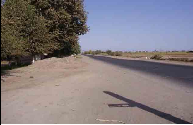
ドゥスティからコルホゾバッドに向かう距離標 53+000 付近、20~40m の波長で道路延長方向に大きく波打つ凹凸が続く
