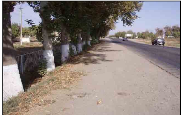
ドゥスティからコルホゾバッドに向かう距離標 49+000 付近、10~40m の波長で道路延長方向に大きく波打つ凹凸が続く
