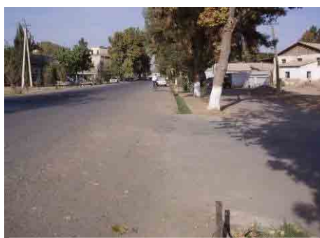
コルホゾバッド市内、車道幅員は13~14m、路面は平坦で舗装状態は比較的良好
