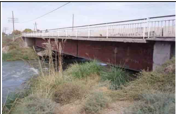
距離標 27+200、幅員：10.5m、歩道：2@1.2m、橋長：52.0m （鋼桁）、部分改修：橋面舗装
