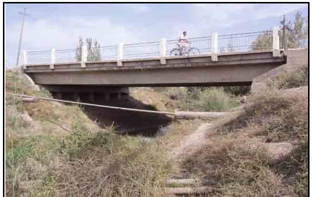
距離標 29+800、幅員：8.2m、歩道：2@1.0m、橋長：9.0m（RC） 幅員が狭く RC 桁の耐荷力の調査を要する。
