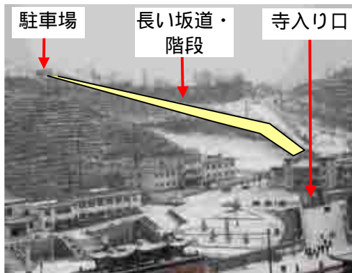
駐車場の不備
