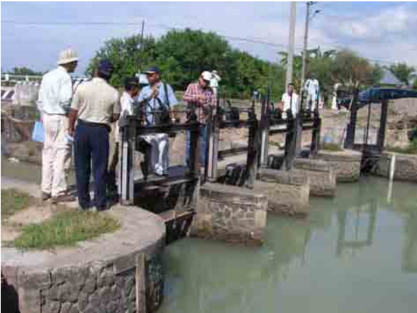
一次水路分水工視察
