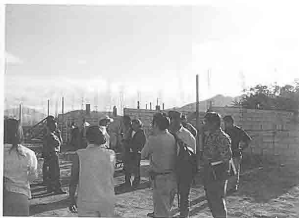
コミュニティによる学校建設(コパン県サン・ヘロニモ市)
