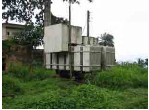
既設変電所の様子 [ウイルバーフォース変電所(左)及び 33 / 11 kV 変圧器(右)]
