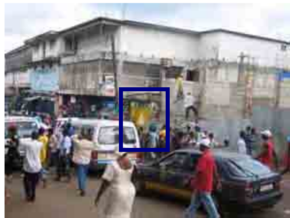
既設 2 次変電所の様子
