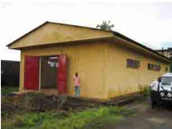
ブラックホールロード変電所の様子
