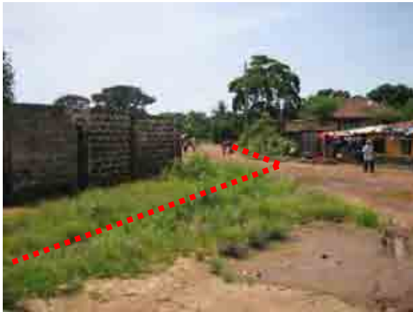
埋設配電ルート
