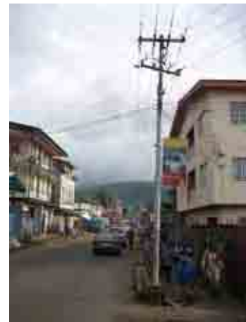
既設鋼管柱の設置状況
