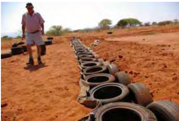
古タイヤを用いた土壌保全構造物 (コミュニティ土壌保全プロジェクト)
