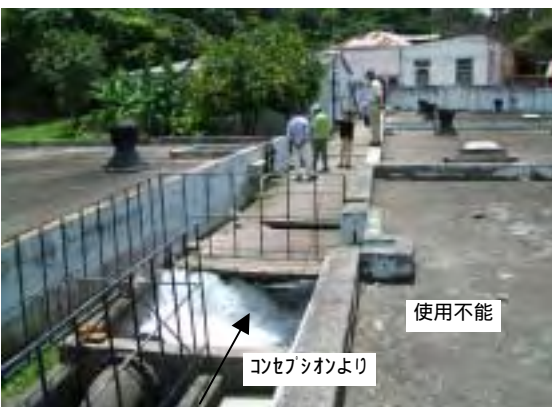
[写真-11] ラ・レオナ配水池
