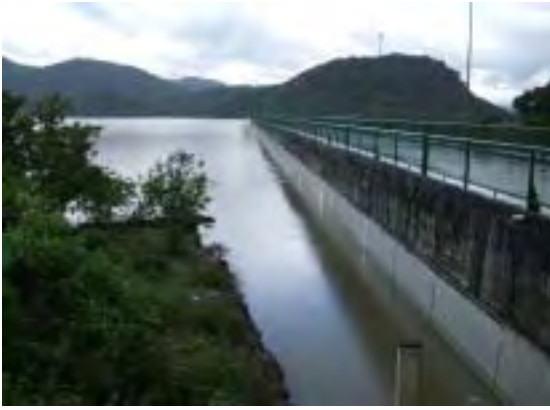
[写真-19] コンセプションダム 貯水量は3300万 m^3 、コンセプション浄水場の取水源である。 現在イタリアの援助により、貯水量の拡大のための改修工事が進められている。 一年を通じてほぼ安定した貯水量があるが、10年に2回ほどは満水にならない年もある。
