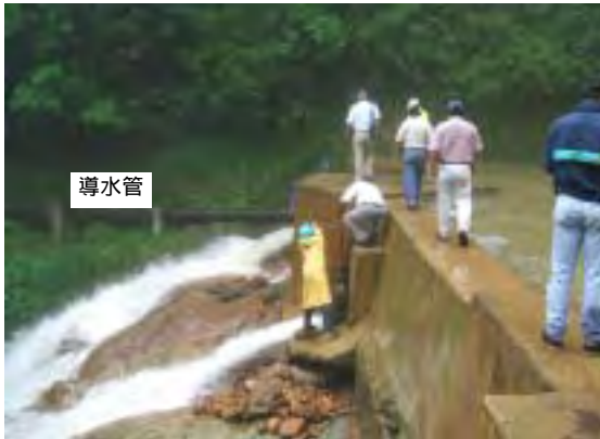
[写真-25] サン・ファンシート導水システムの取水堰(アゲア・カトル) ここを含む計7箇所の取水堰において、堰の高上げによる貯水量増加と蛇籠工による補強が要請されている。 しかし、導水量の大幅な拡大を図ることは難しく、改修による効果は低いと考えられる。
