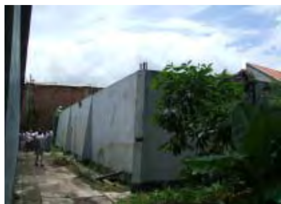
[写真-12] カナル11配水池
