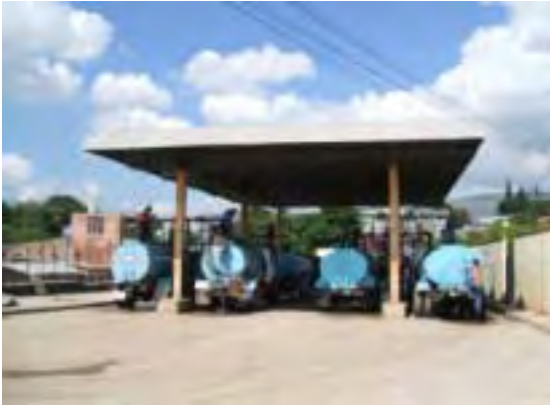
[写真-13] 既存の給水ステーション ロス・フィルトロスにある給水ステーション。 SANAAに登録された民間給水車(Aquabloc)が使用する。1日に60～100台程度がここを拠点に市周辺部の住宅地に水を運搬している。 貧困層の住宅地が急速に拡大しているため、新たな給水ステーションの整備が要請されている。
