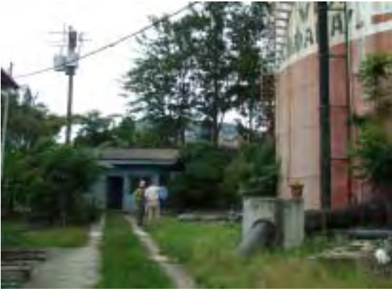
[写真-7] オリンプ 配水池
