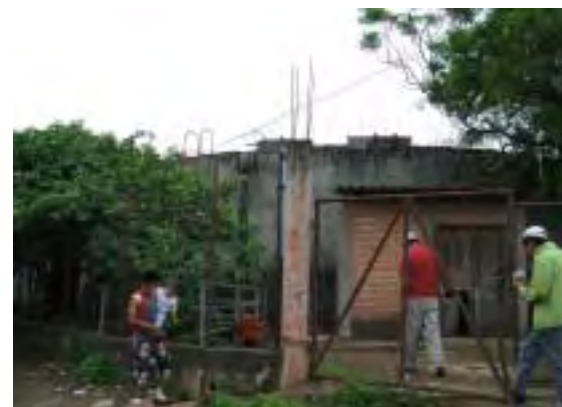
[写真-10] ラ・ソサ配水池
