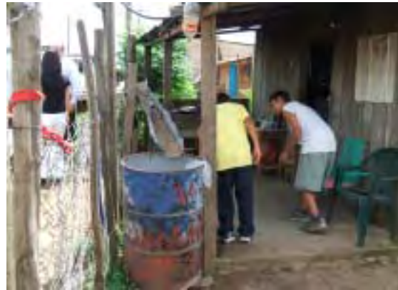
[写真-14] 給水車による給水地域 標高が高く、配水管網による給水ができないため、給水車から水を購入する。 運搬日は月に数回と限られているため、雨水をドラム缶に貯水する施設を有しており、水不足に備えている。
