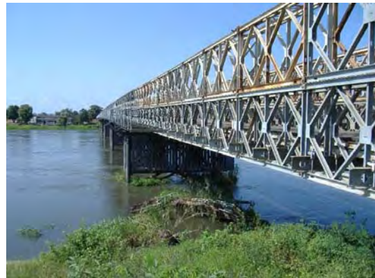
ナイル川仮設橋
