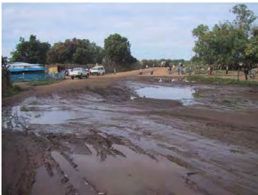
降雨後の道路状況
