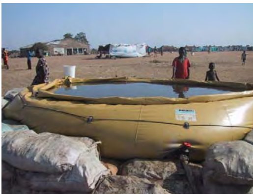
給水車による売水用仮設水槽
