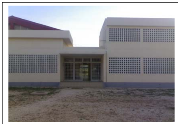
Campus social : annexe des nouveaux locaux
