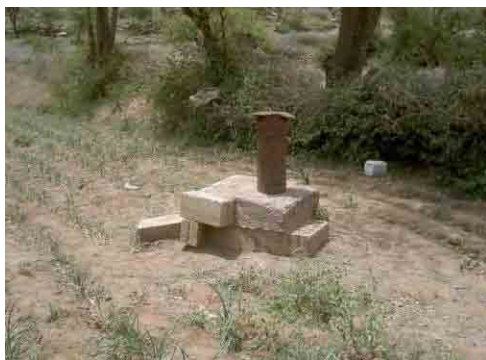
写真-1 Bany Surwr 村により建設された深井戸 1998 年建設、深度 190m、揚水量 74 ガロン/min、静水位 129m、動水位 140m。この井戸から既存配水タンクに導水し、350 世帯の約 2,450 人に給水する計画。
