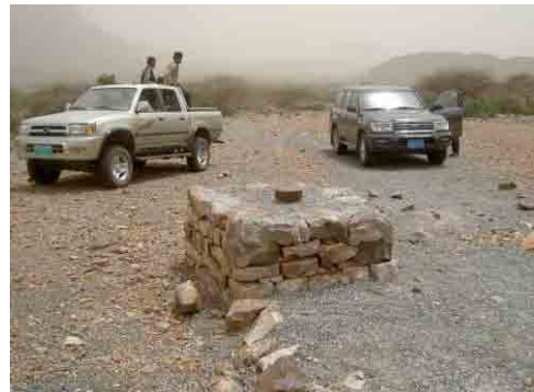
写真-36 Al Shaafel 村の深井戸 2004 年に地方議会が深井戸を建設。深度 192m。現在住民 は浅井戸からロバで運搬している。周辺に深井戸ない。
