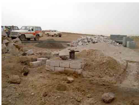
写真-22 Masnat Abdalaziz 村の建設中揚水ポンプ場
