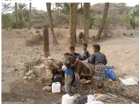
写真-7 Al Khunah 村の深井戸 GARWSP による 2005 年 1 月建設された自噴井戸。深度 200m、揚水量 8.8ℓ/sec、動水位 5.58m、EC=1,180 μ S/cm、水温 41°C。標高約 540m の気温の高い地域に位置。
