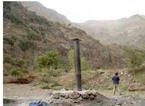
写真-16 Asfal Bany Saba 村の深井戸 2005 年 4 月 GARWSP 建設の深井戸。深度 305m、揚水 量 60 ガロン/min、静水位 180m、動水位 210m。井戸から 前方山地頂部の配水タンク予定地まで 580m の標高差。
