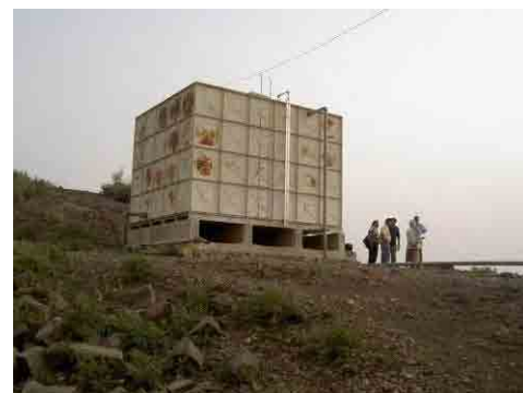
写真-4 Al Muayteeb 村配水タンク 日本の 1982~84 年無償によるパイプ給水施設。配水タンクは 120m 3 。6~7 年前から深井戸の水量減ったため使っていない。
