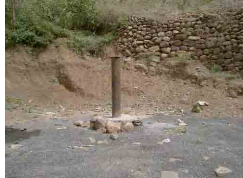
写真-12 Al Sana 村の深井戸 2005 年 3 月 GARWSP 建設の深井戸。深度 272m、揚水量 75 ガロン/min、静水位 39m、動水位 201m。井戸から配水タ ンク予定地までは 560m もの標高差がある。
