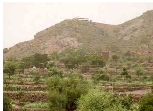
写真-6 Al Azaiz 村配水タンク 220m 3 (写真)、150m 3 、75m 3 の 3 つの既存配水タンク、既存水源の深井戸 2 本と泉 1 ヶ所。2004 年 GARWSP 建設の深井戸 1 本から新規計画 500m 3 配水タンクへの導水。
