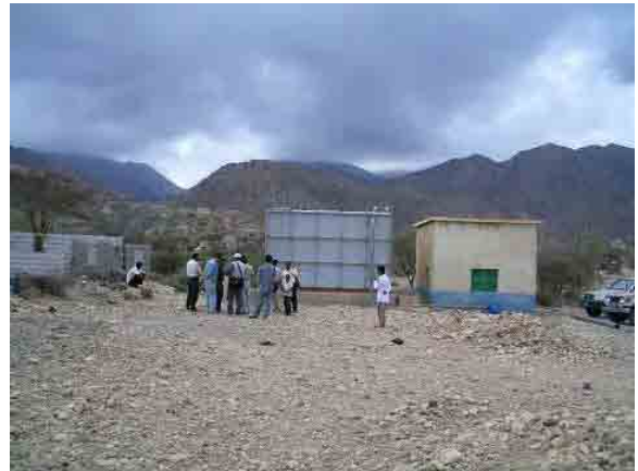
最終貯水槽、GARWSP により新設されたポンプ施設
