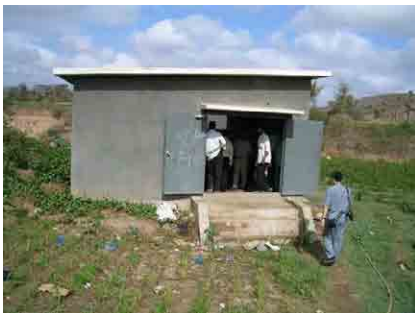
No. 3 井戸ポンプハウス
