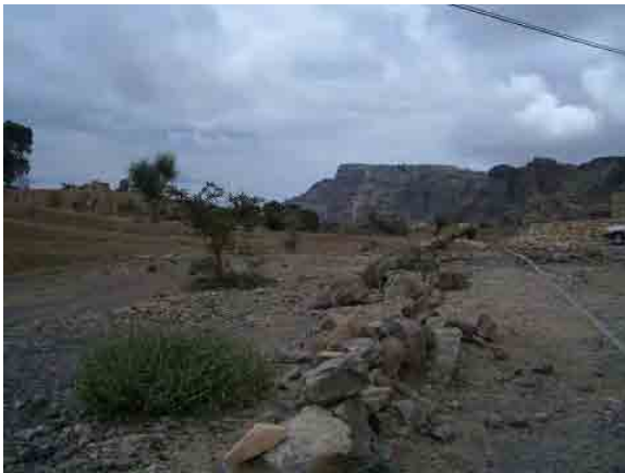
最終配水貯水槽は向こうの山上にある
