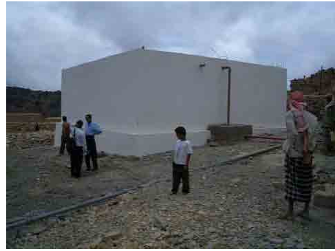
第2中継施設すぐ横に建設された私設貯水槽
