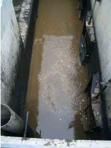
スクリュウポンプおよび最初沈殿池（1次処理） 沈砂池の固形廃棄物除去装置
