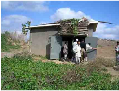
No. 2 井戸ポンプハウス
