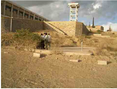
第2貯水槽および配水用貯水タンク
