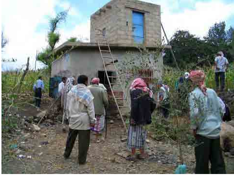
水源井戸およびポンプ小屋
