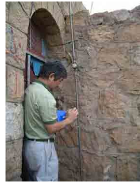
各戸の水道メーター
