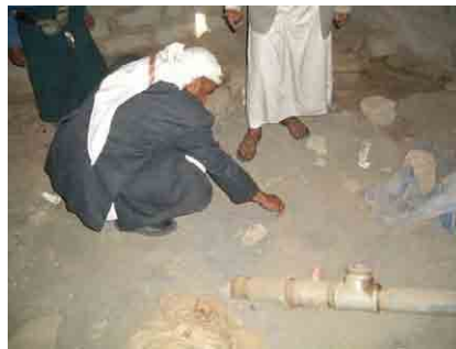
既設井戸箇所でのさく井
