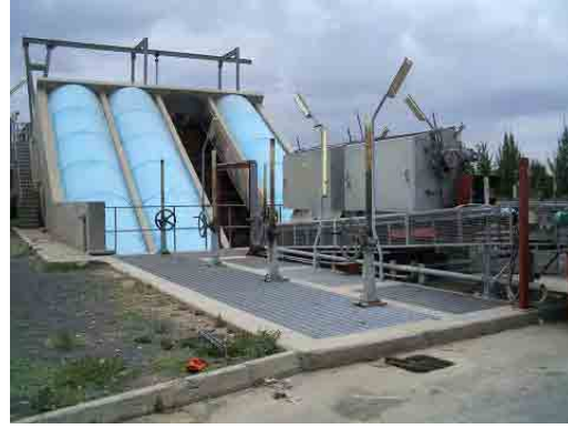
スクリュウポンプおよび最初沈殿池（1次処理） 沈砂池の固形廃棄物除去装置
