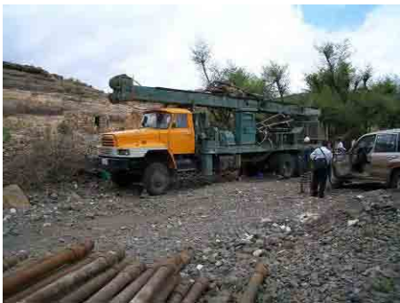
GARWSP のさく井部隊、日本供与の利根（リグ）到着 120m 離し、新井戸をさく井する。
