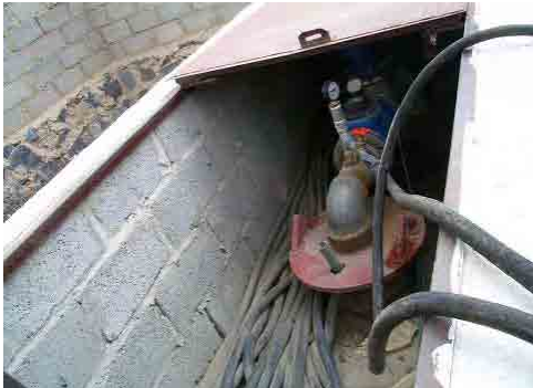
井戸、水位観測ガイドパイプあり
