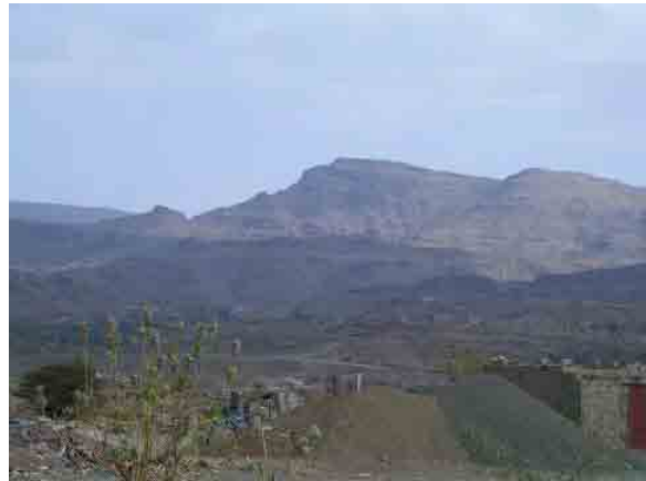
ワジ内の水源より遥か山上まで送水パイプにより給水
