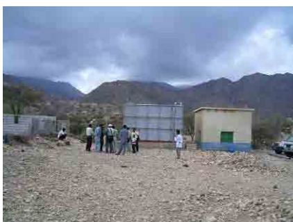
最終貯水槽、横は GARWSP の新設ポンプ施設
