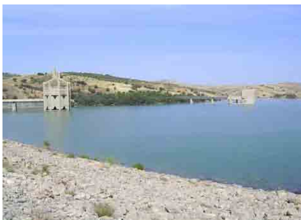
7. Sidi Salem ダム貯水池
