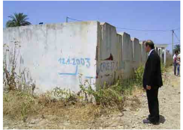
34. Bou Salem 町の排水路近くの氾濫マーク
