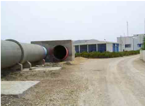
29. Sidi el Barrak ダム貯水池からのポンプ場とパイプライン
