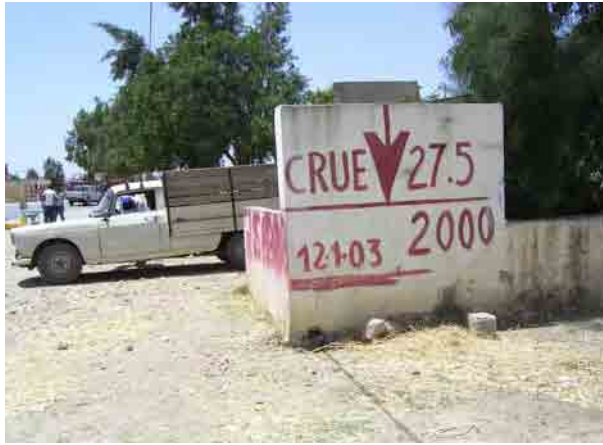
33. Jendouba 町道路沿いの氾濫マーク
