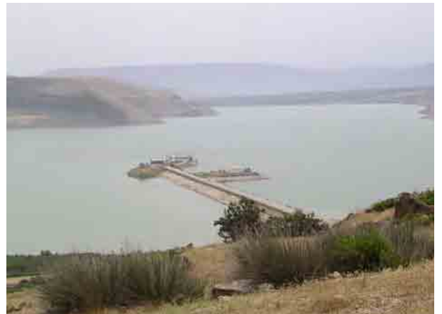
28. ポンプ場とパイプライン(Sidi el Barrak ダム貯水池)
