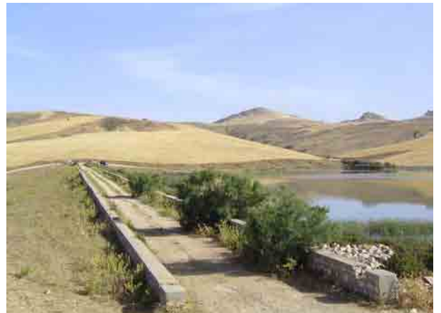
14. Sidi Salem ダム近くの Hill ダム
