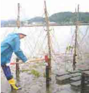
潮間帯に鉄の杭を打ち込み、そこに笹竹を取り付ける。
