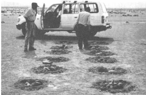
写真1 ダブルサック工法施工直後
