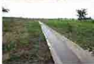
堤体下流部の取水の減勢池とそれに接続された灌漑水路。
