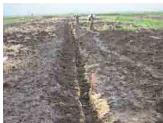
暗渠の埋め戻し状況。表面を平らにして完成
