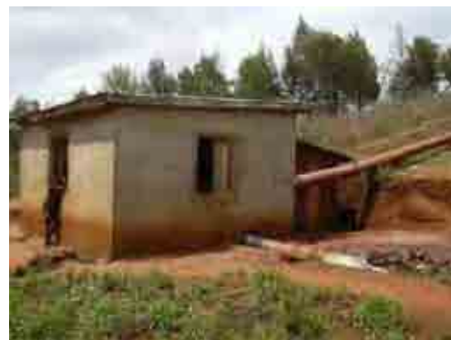
水が落ちる製粉小屋と排水
