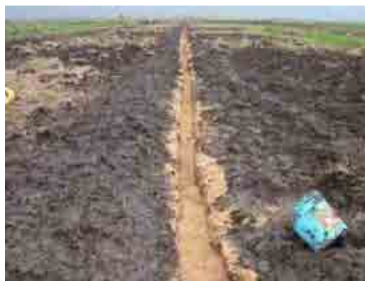
暗渠の掘削後籾殻を充填した状況
