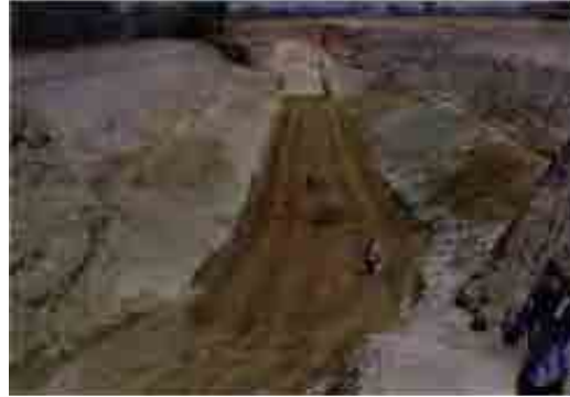
掘削後の不透水土堰堤の築堤工事
