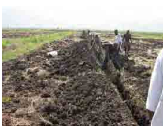
暗渠の農民による掘削状況
