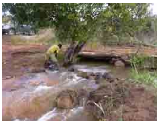
石で川をせき止め、右方向に取水する
