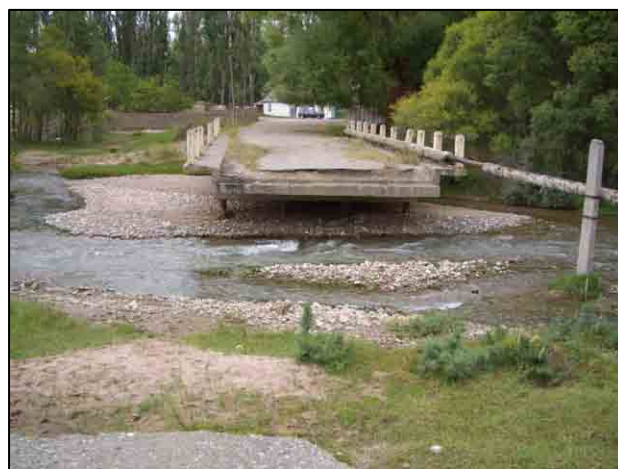
旧道部（橋梁部）
