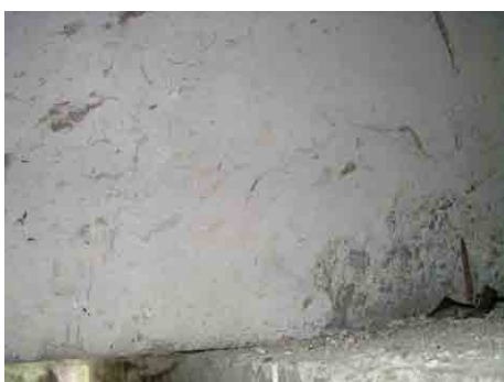
No.19 橋梁 橋台部
