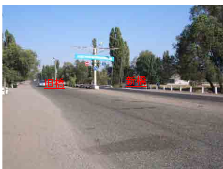
橋梁部分道路全景(「ウ」国に向かって)
