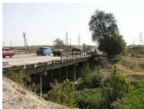
②上流側の丘の上から橋方向を見た光景。橋梁周辺に樹木があり迂回路等を設置する際には伐採が必要。
