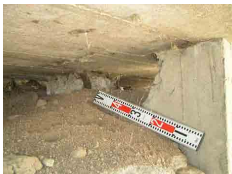
No.23 下部工部
