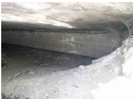
No.15(1)橋梁 橋台部
