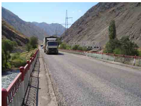
No.25 橋梁全景
