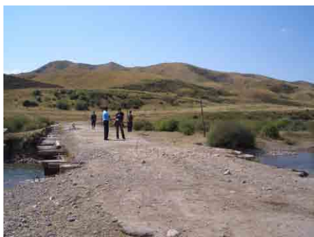
橋梁部分道路全景
