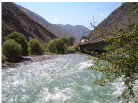
No.25 橋梁全景
