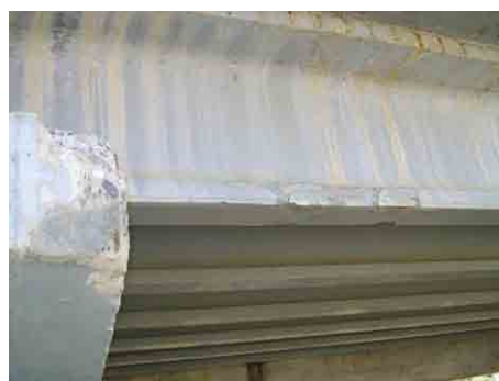
主桁部 塗装されている
