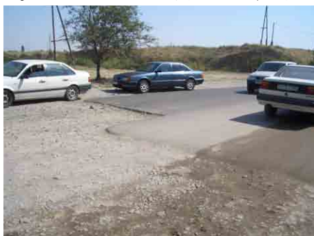
ADB による舗装改修工事
