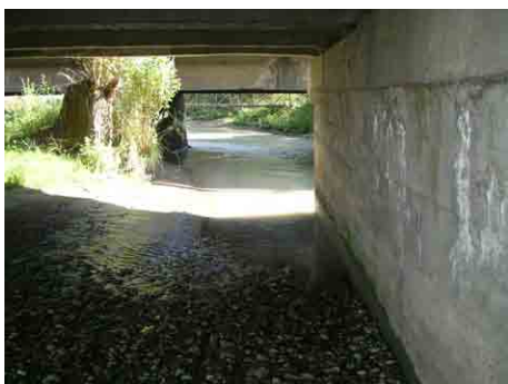
No.14(2) 下部工の状況
