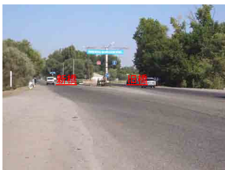
橋梁部分道路全景(Torugart 方向)
