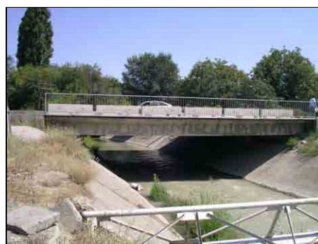
No.9 橋梁全景
