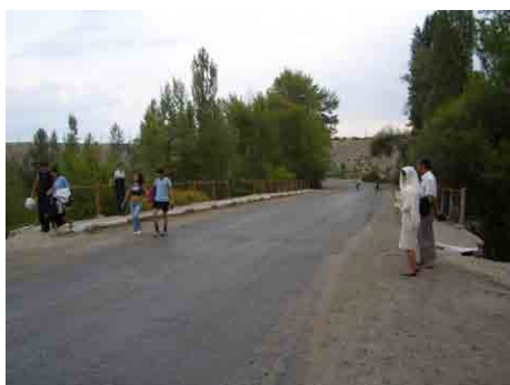
橋梁部分道路全景(Karakol に向かって)
