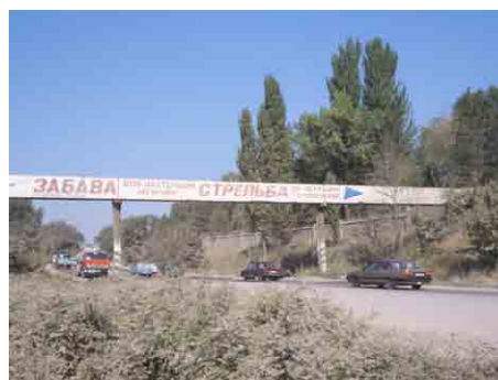
橋梁を挟んで両方向にある水管橋
