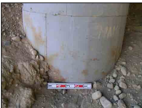
No.22(2) 補強された橋脚部
