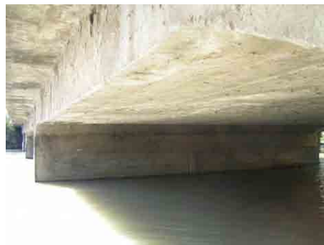
No.15(1)上部工の状況
