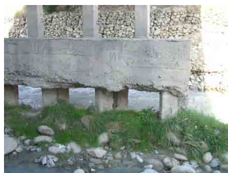
No.2 橋梁下部工部
