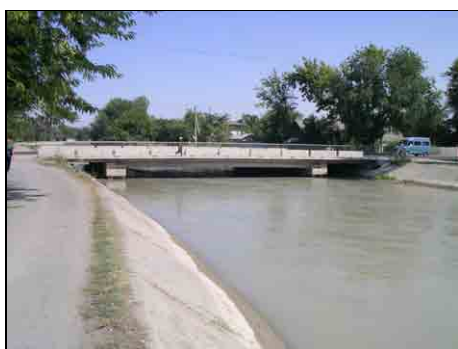
No.8 橋梁全景
