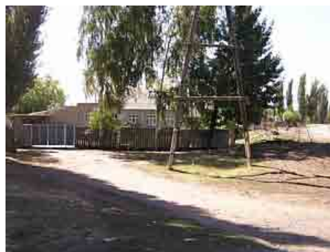
②住宅地が隣接している。送電線が橋梁近傍を通過 しており、鉄塔(木塔)も橋のすぐ近くに設置され ている。
