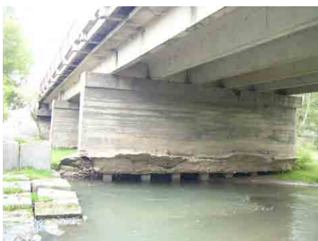
No.19 橋梁 橋脚部
