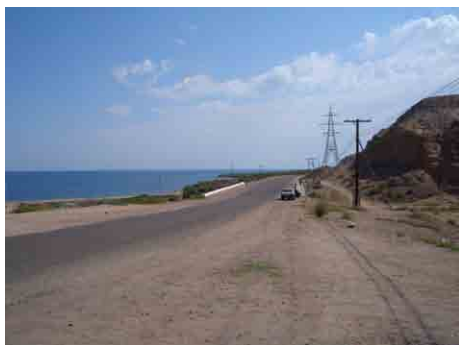
橋梁部分道路全景(Karakol に向かって)
