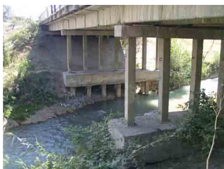
No.1 橋梁下部工部
