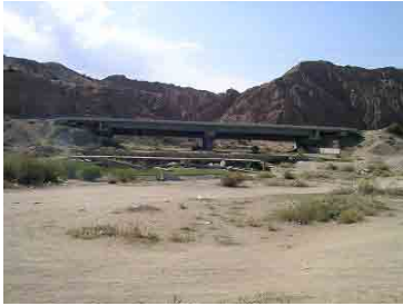
下流部からの全景
