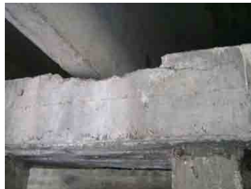
新橋建設の為はつられた旧橋台
