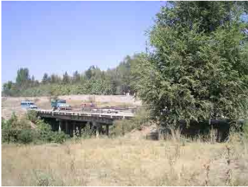
下流部からの全景
