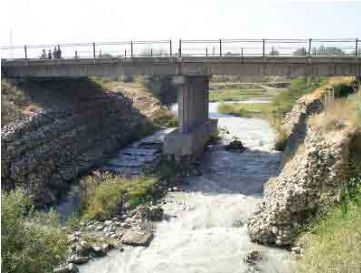
上流部からの全景
