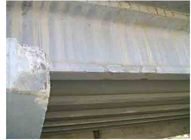
塗装された主桁
