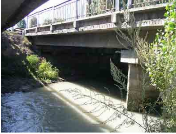
下流側からの全景
