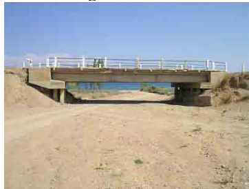
上流部からの全景
