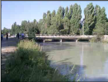
上流側から全景
