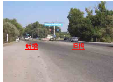
分離された上下線(橋梁部)
