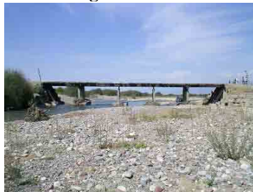
上流部からの全景
