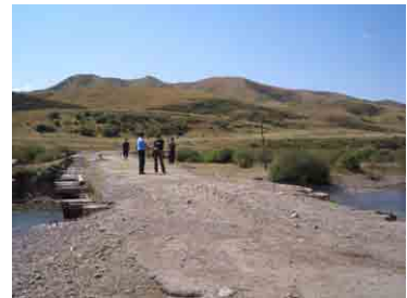
未舗装の対象橋梁道路
