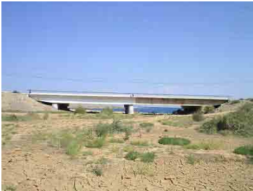
上流部からの全景
