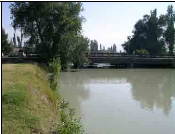
下流部からの全景
