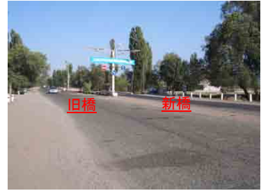
分離された上下線(橋梁部)
