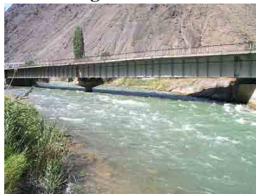
下流側からの全景
