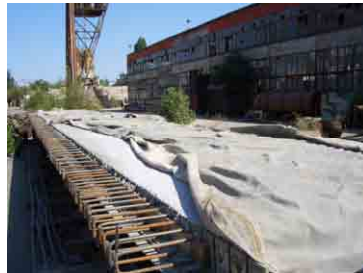
RC 桁養生状況
