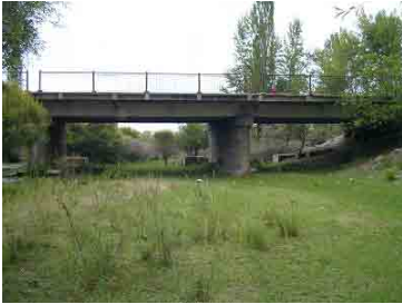
下流部からの全景
