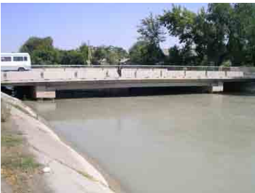
上流部からの全景
