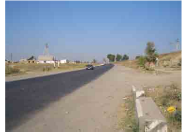
道路全景 (Tashkent 方向)
