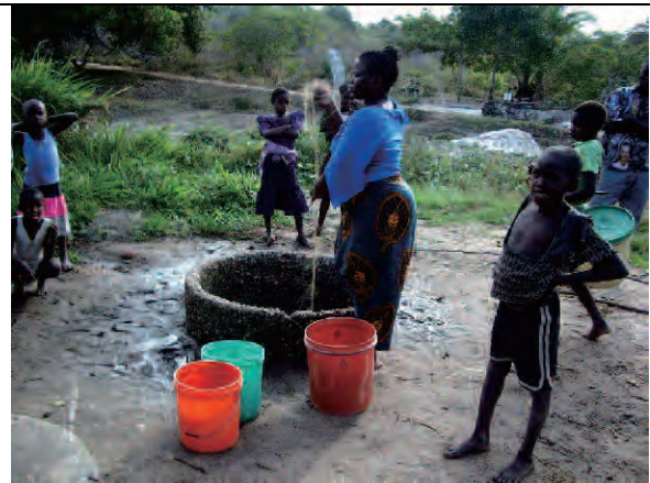
写真-4：素堀井戸から水を汲む住民。地表からの汚染防止も不十分で汚染された浅層の地下水を利用するため非衛生的である。
