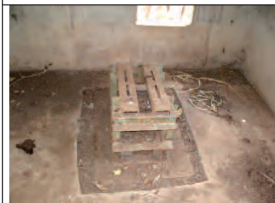
写真-5：老朽化し更新されないまま放棄された取水施設の内部
