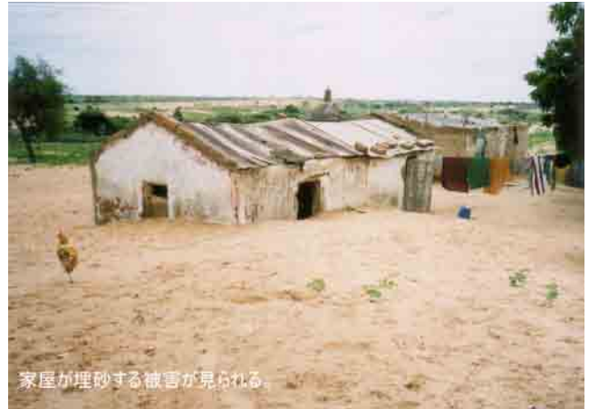
1/2期事業前 飛砂被害(家屋の埋砂)
