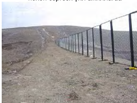
Хог хаягдлыг замбараагүй хийсэх байдлаас сэргийлэх зөөврийн хашаа
