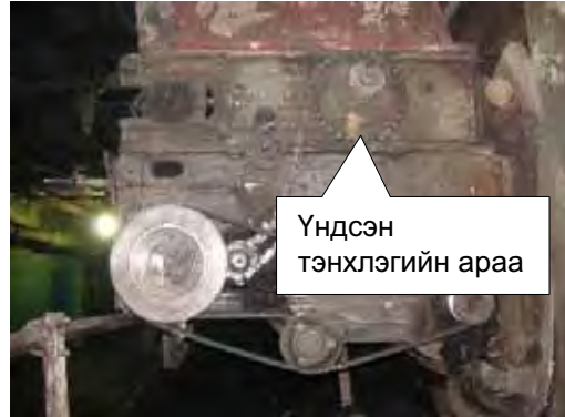
Нүүрс шидэгч конвейер
