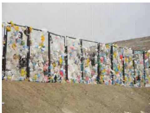
Зөөврийн хашаа ашиглан хог хаягдлыг замбараагүй хийсэх байдлаас сэргийлэх
