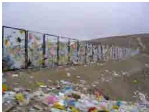
<Хамгаалах далан ба хог хаягдал замбараагүй тархах байдлаас сэргийлэх торон хашаа> Хогийн төвлөрсөн цэгийн урд талд хамгаалах далан болон хог хаягдал замбараагүй тархах байдлаас сэргийлэх торон хашаа барив.
