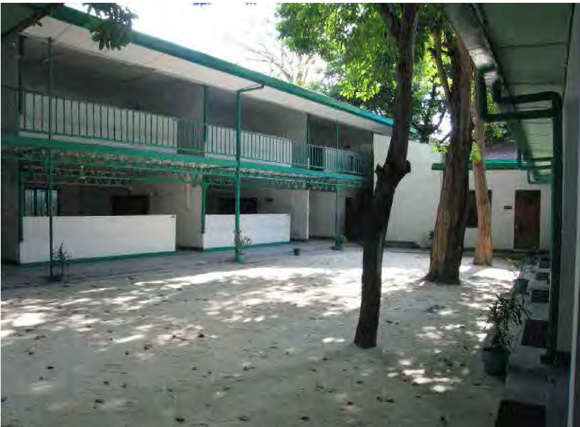
写真-5 : アミニヤ女子中学校 教室と廊下の間にはサッシが無く、教室は外部から吹きさらしの状態にある仮設校舎。
