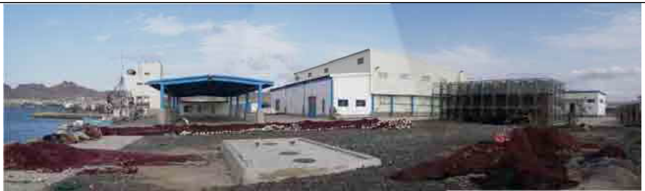
写真-2：敷地西端より見た漁港施設の現況。
