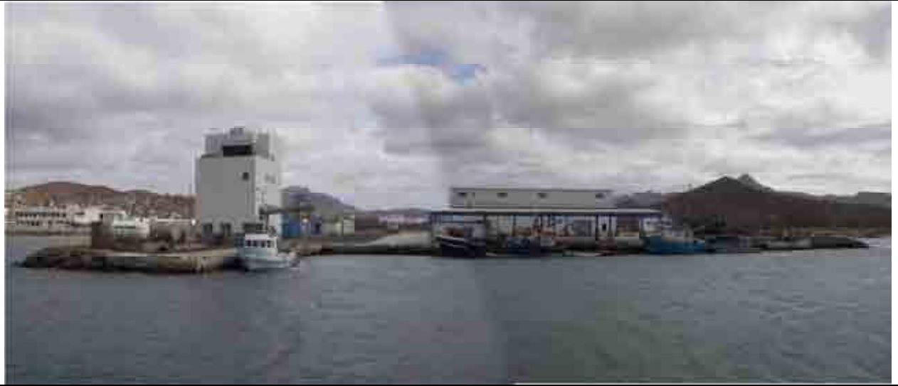
写真-1：海側防波堤より見た CPCI 施設の現況
