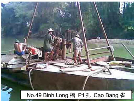
地質調査：水上ボーリングの状況
