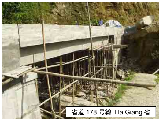
実施能力：ベトナム側単独施工の RC 橋梁
