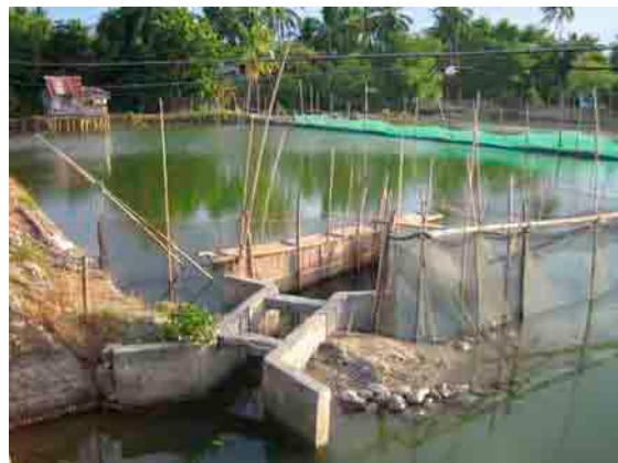
C-4 ミルクフィッシュ養殖池の取水口
