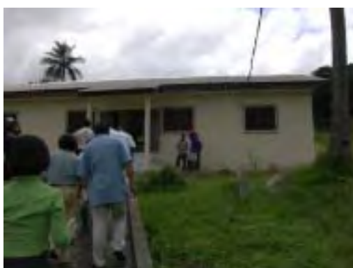
写真 36 新設の敷地内の研修施設
