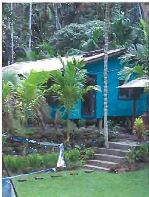
屋根に設置されたPVパネル
