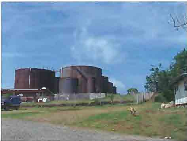
燃料タンク及び新発電所予定地 (タンク右手前からタンク右手のフェンス両側)
