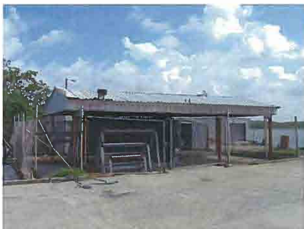
揚油栈橋にある揚油施設
