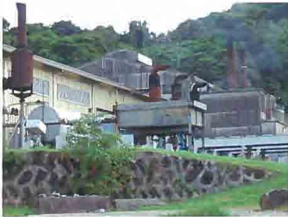
発電所煙突（奥の2本が三菱重工発電機用、中央の3本がワルチラ社発電機用）
