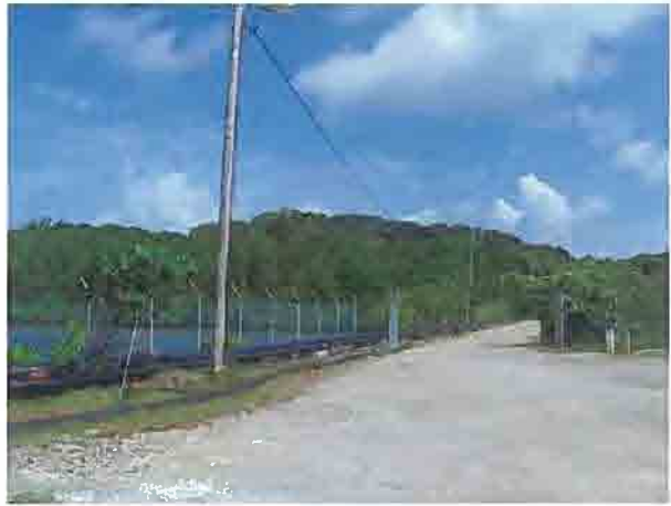
タンクまでのパイプライン
