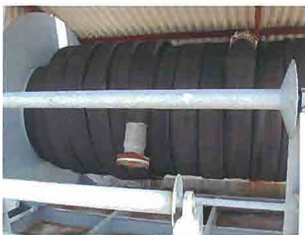
揚油用のパイプ
