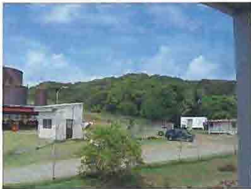
新発電所予定地全景 (道路からタンク右側)
