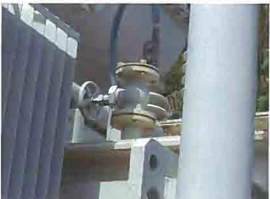
ガスケットの劣化によるオイル漏れ
