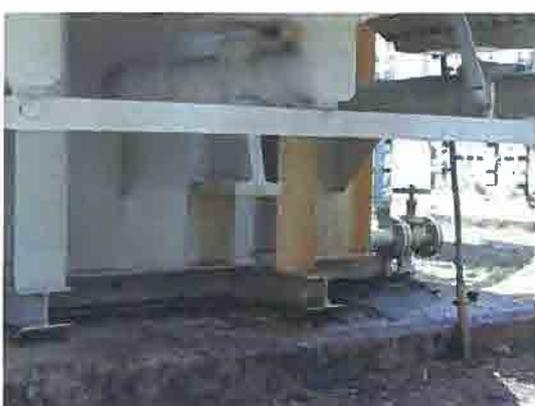
No. 2 変圧器の側面の錆と下部ボルトナットからの錆
