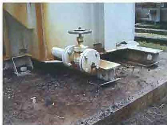
No. 2 変圧器のバルブのガスケット劣化及びボルトナットの錆
