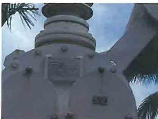
No. 2 変圧器のブッシング下部のガスケットの劣化
