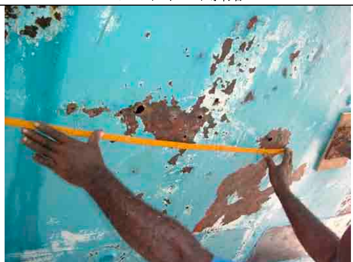
船底に腐食開口した穴
