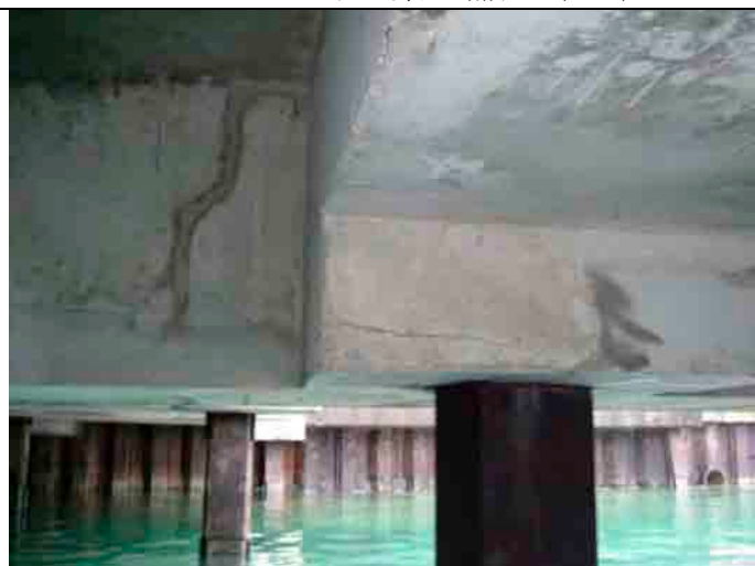
コンクリート床・梁の補修 (ADB)
