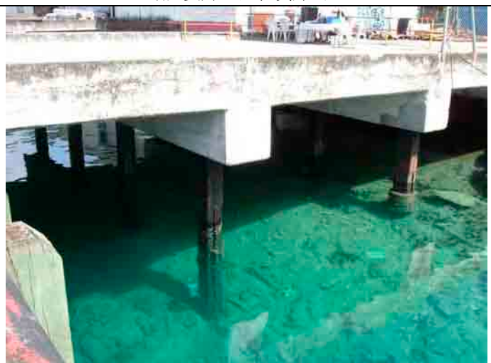
連絡橋、箱型鋼管杭
