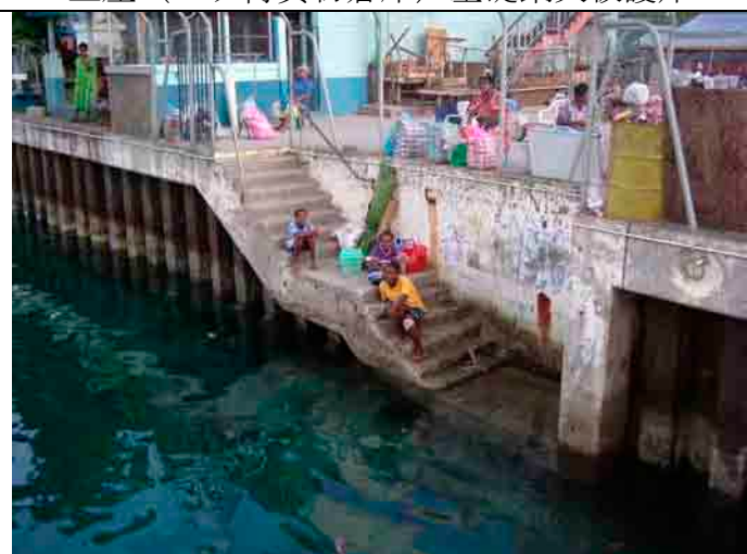
鋼矢板護岸及び小型船舶係船岸
