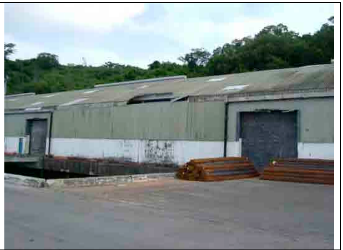
上屋前連絡橋
