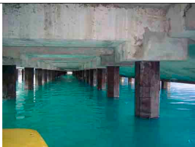
鋼材巻き補強 (ADB)
