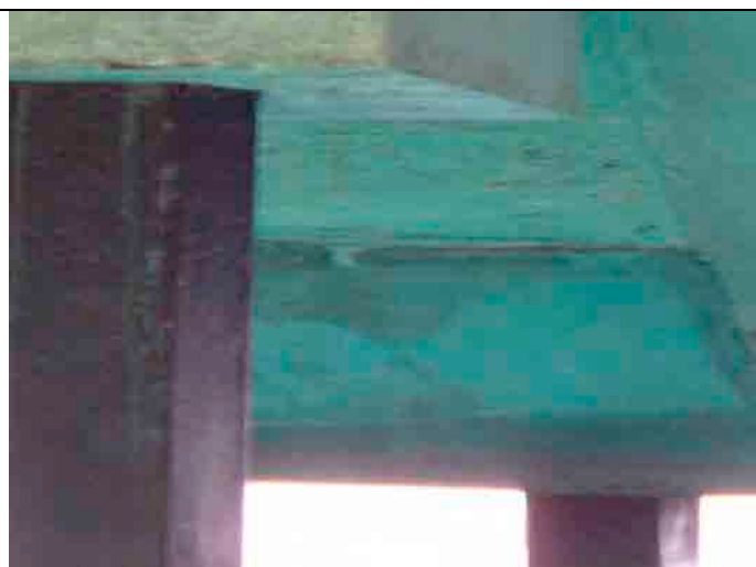
コンクリート床・梁の補修 (ADB)
