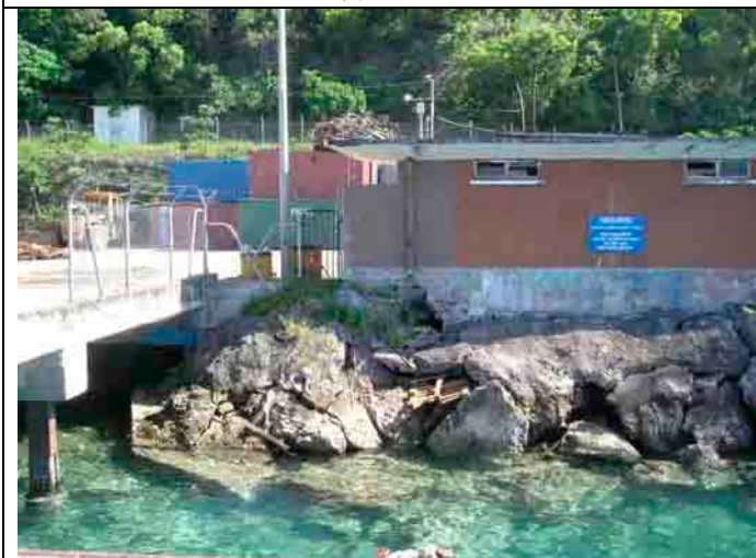
連絡橋及び作業員便所兼シャワー室
