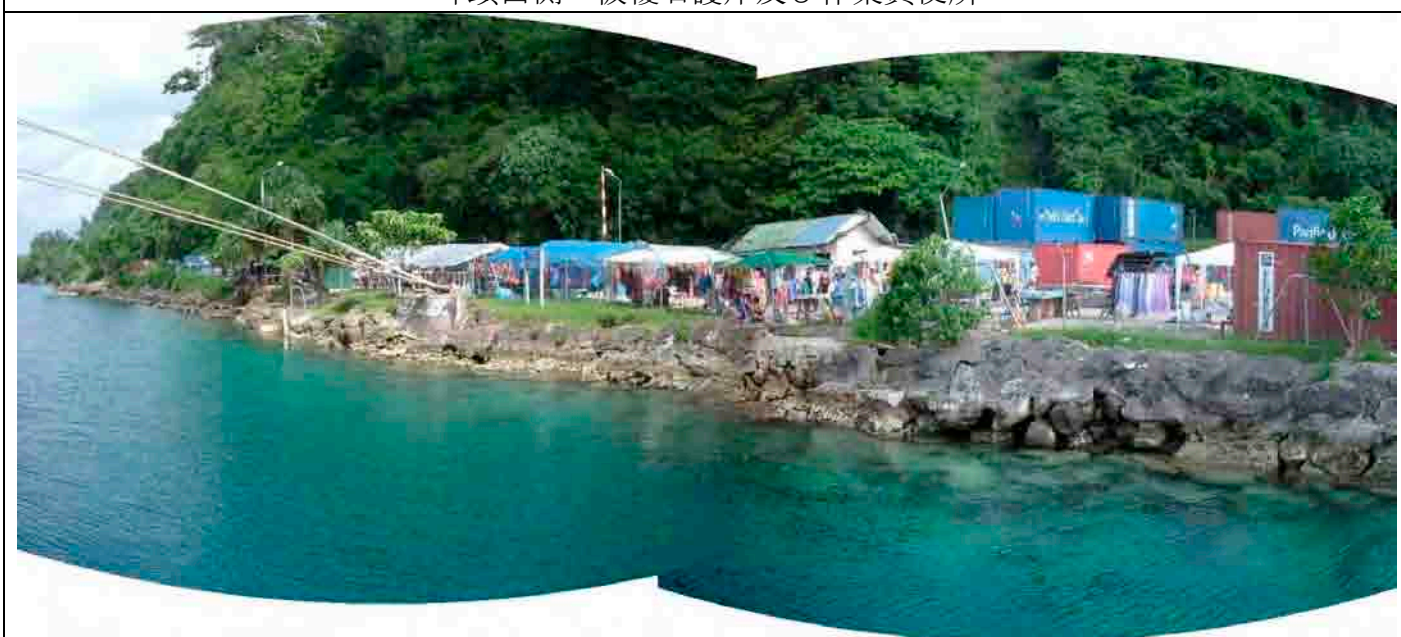
埠頭西側 被覆石護岸及び作業員便所
