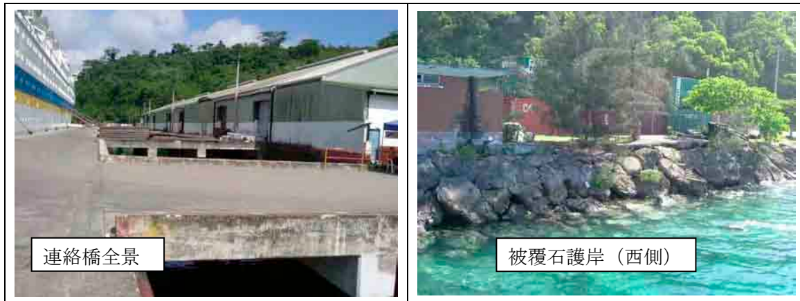
写真 2-2-3 連絡橋、護岸状況
