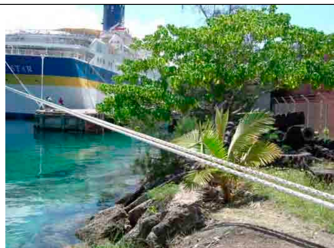
埠頭西側 被覆石護岸
