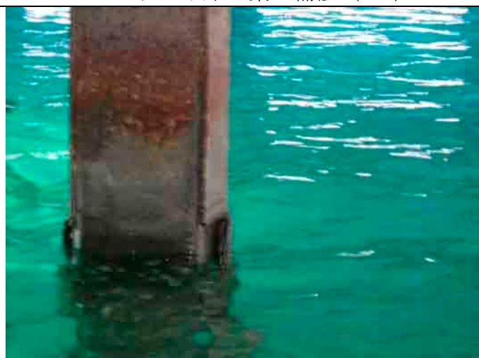
鋼材巻き補強 (ADB)
