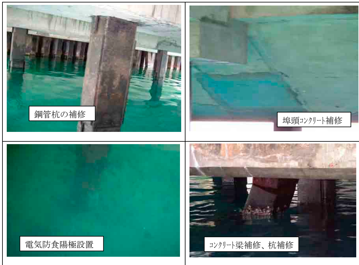
写真 2-2-12 ADB 補修作業後状況
