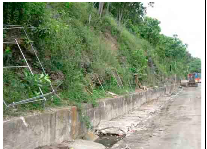
場内排水施設及び切取り法面
