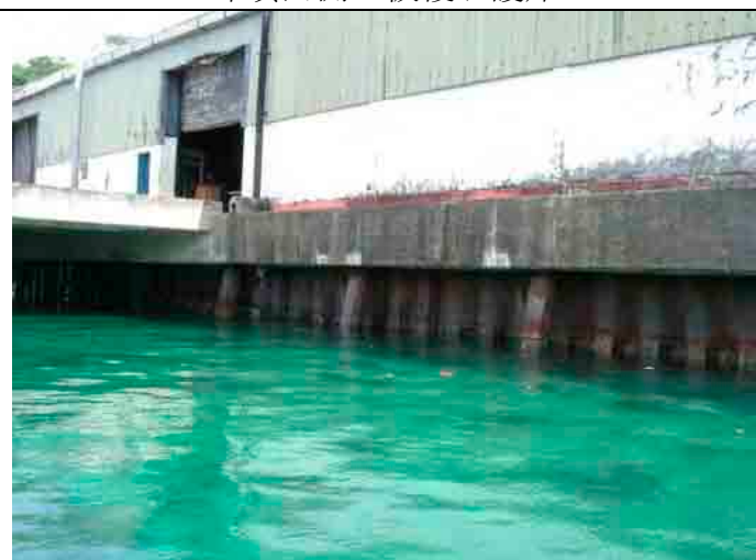
上屋（バラ荷貨物倉庫）基礎鋼矢板護岸
