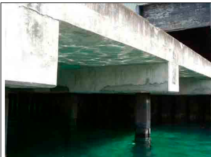
コンクリート床・梁の補修 (ADB)
