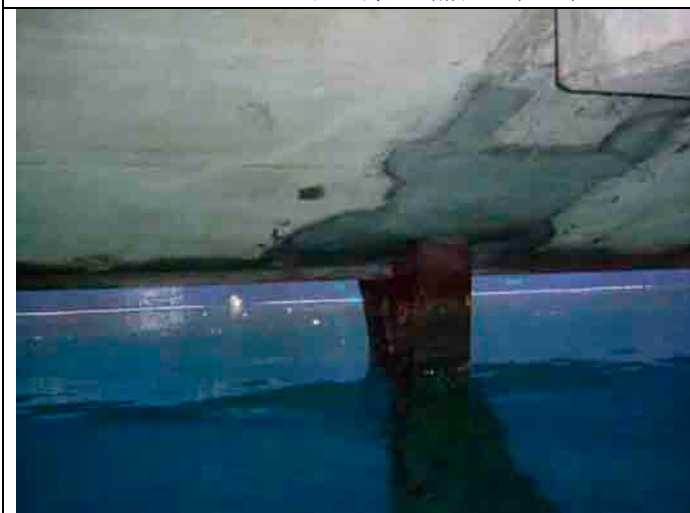
コンクリート床・梁の補修 (ADB)
