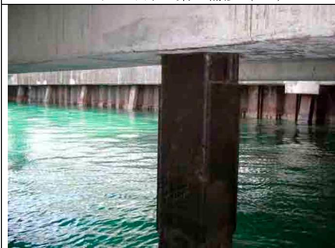
鋼材巻き補強 (ADB)
