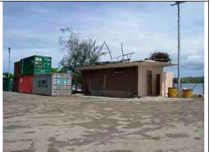
作業員便所兼シャワー室
