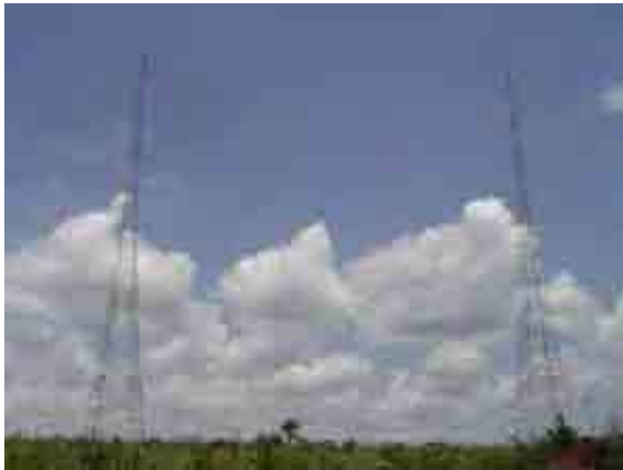
マワガ中波送信所 / 既存送信アンテナ 1972年に建設された高さ130mの自立式送信アンテナ鉄塔。隣国タンザニアへの影響を抑えるため指向性をもたせたものとなっている。
