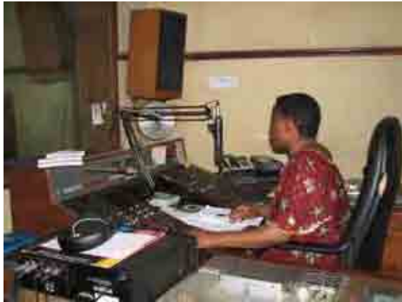
UBC 本部 / オンエアスタジオ コントロール室 ブルー、レッド、プテボの各チャンネルごとに1つのオンエアスタジオを有する。主な機材は 24 チャンネル音声ミキサー、カセットレコーダー、オープンリールテープレコーダーなど。すべてアナログ機材で構成されており、動作不安定で故障も多い。
