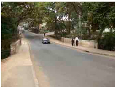
(8) 橋梁の幅も不足 ((5)と同じ)
