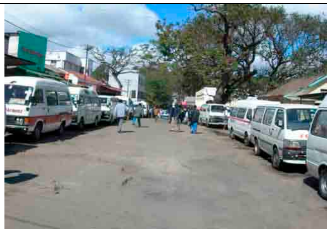
リンベ商業地 (Market Street)。両脇のミニバスの駐車と舗装の劣化で車両走行に支障が生じている。
