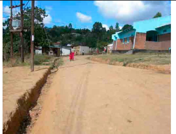
世銀の支援プロジェクト MASAF (Malawi Social Action Fund) によって整備された土道路と側溝。
