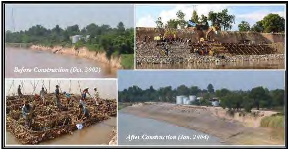
図 9.4.2 バン・ドンフォシサイト護岸・施工状況
