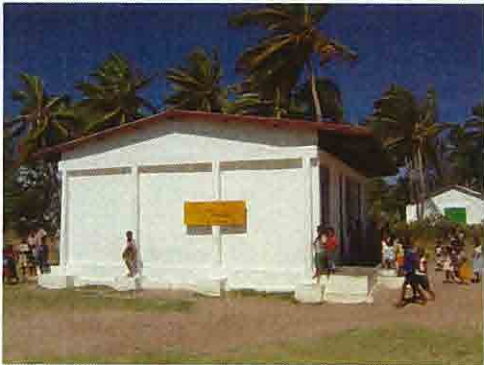
1960年「マ」国建設、AIDE ET ACTION 改修教室
