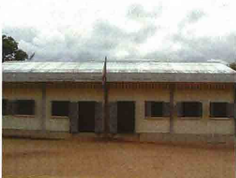
2003年CRESED II建設教室棟
