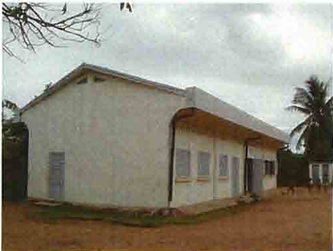
2003年 CRESED II 建設教室棟
