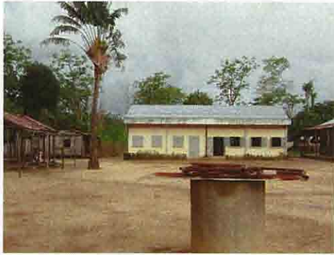
2003年 CRESED II 建設教室棟
