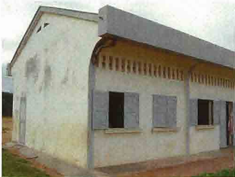
2003年 CRESED II 建設教室棟
