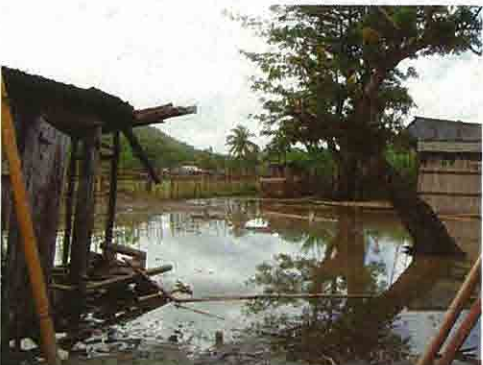
水はけの悪い敷地
