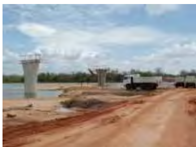
ユニティー橋建設状況
