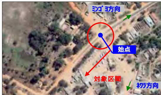
写真-3: 対象道路の始点付近
