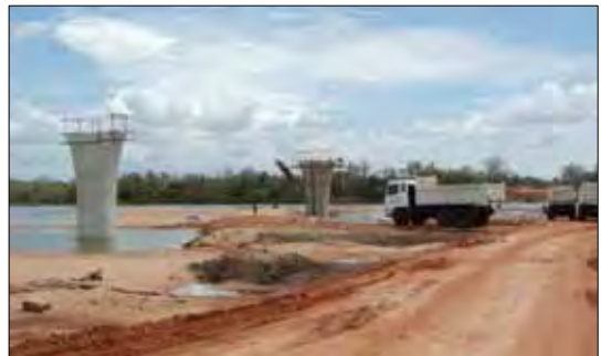
写真-8: 関連プロジェクトの進捗( 建設の進むユニティー橋)
