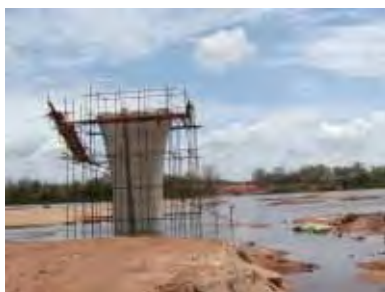
施工中のユニティー橋橋脚
