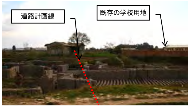
学校に隣接した家屋 (1+850km付近)
