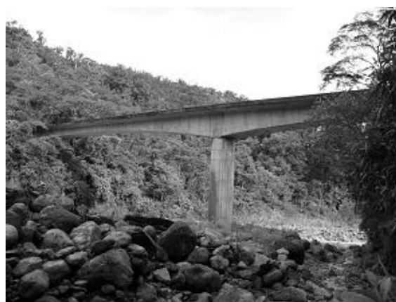
Figura 10.3.4. Depósito de Grandes Rocas en el Puente río Sucio No.20
