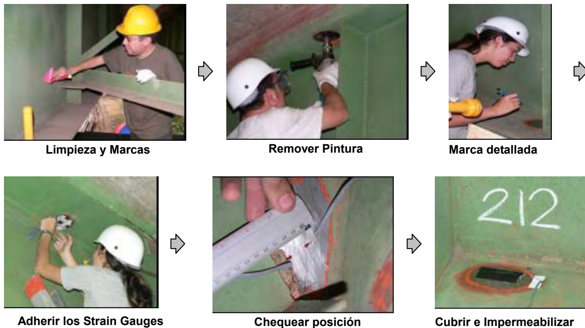
Figura 10.2.24. Instalación de Strain Gauges
