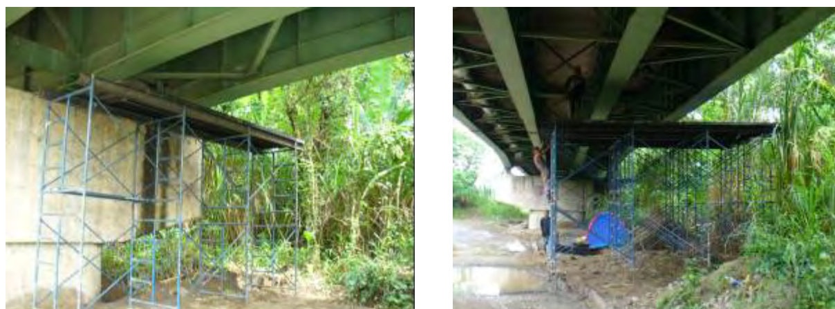
Figura 10.2.22. Andamios para las Zonas de Trabajo
