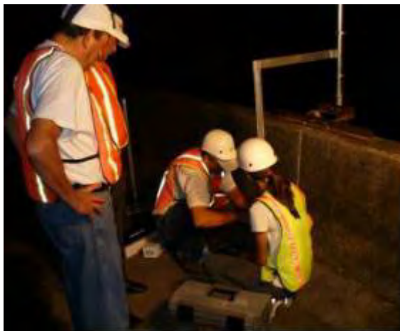
Instalación de los equipos de medición
