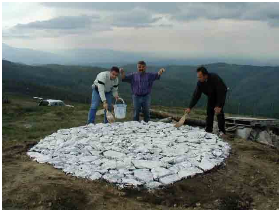
対空標識設置（標定点測量）
