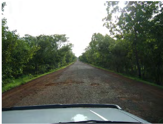
南回廊道路事業 LOT 1 区間現況 (Kedougou～Saraya)
