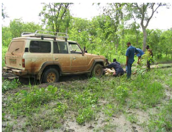
南回廊道路事業 LOT 1 区間現況 (Faleme～Bafing)
