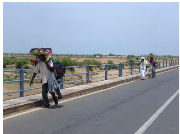
キデラ橋利用状況 (歩道が狭く歩行者は車道を通行)
