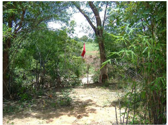
橋梁架橋予定地（右岸側から）
