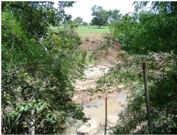
橋梁架橋予定地（右岸側から）
