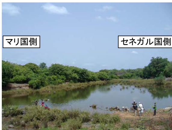
橋梁架橋予定地（下流側から）
