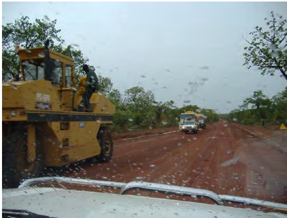
南回廊道路事業 LOT 4 区間現況 (Kita～Kati)
