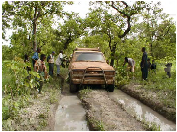
進入路現況(アクセス道路)
