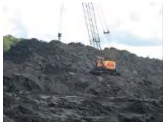
写真 5-2-6 選炭設備周囲の状況
