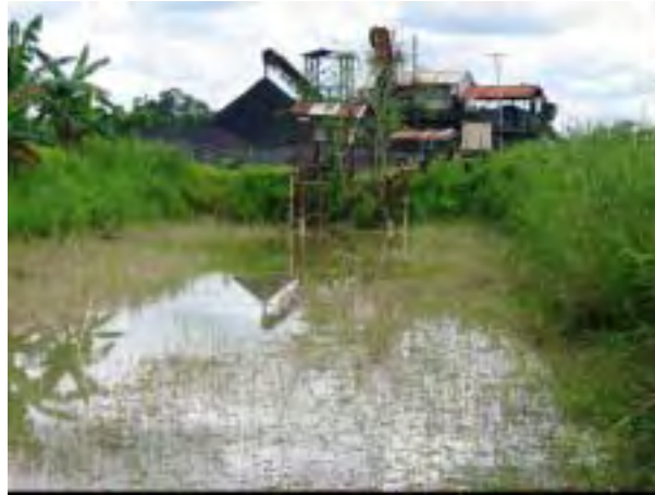
写真 5-2-4 FBS 循環水取水設備
