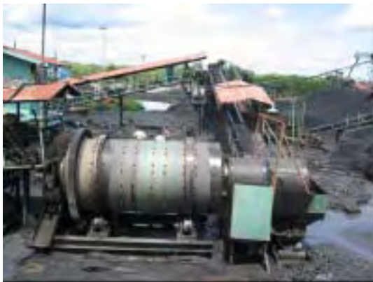
写真 5-2-5 選炭設備設置状況
