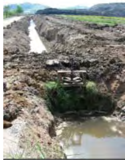
写真 5-2-7 BBE 循環用水路掘削
