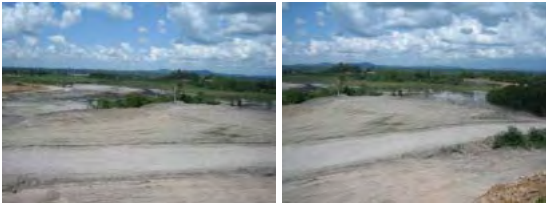
写真 4-2-5 沈澱池の埋立状況
