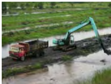
写真 4-3-2 セットリングポンドで微粉炭回収作業
