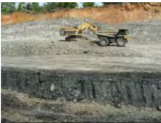
写真 4-3-3 炭層上部のクリーニング作業中、上部の廃棄石炭を除去
