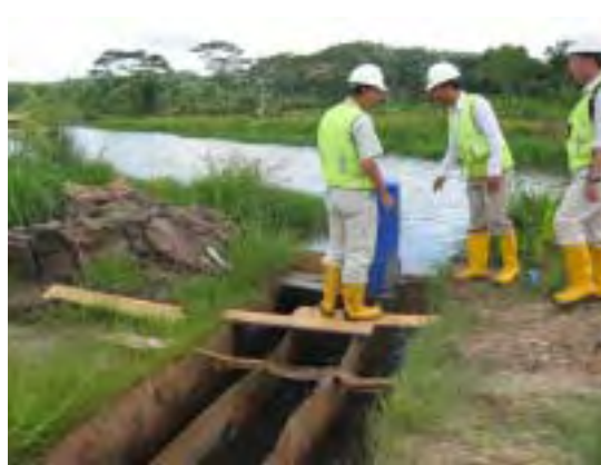
写真 4-2-7 高分子凝集剤添加設備
