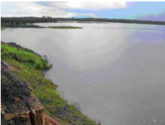
写真 4-5-3 セットリングポンド全景
