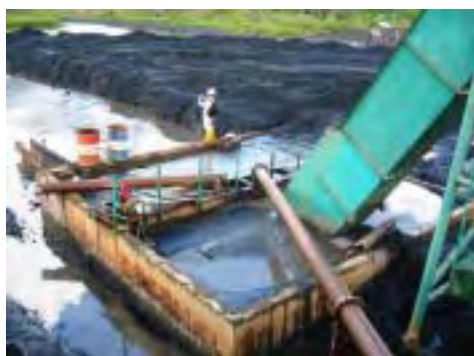
写真 4-2-1 沈降槽と BE
