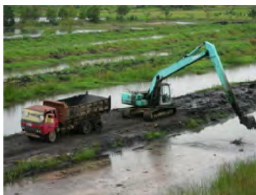
写真2 .セッティングポンドで石炭スラッジ回収作業
